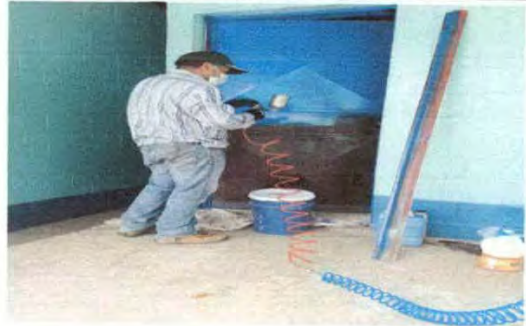
Foto 2: PUERTA DE METAL
