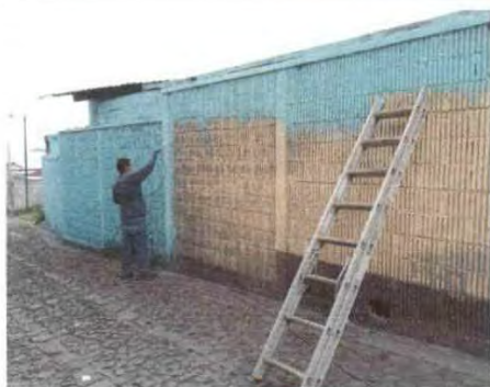
Foto1: PINTURA EN MUROS EXTERIORES E INTERIORES
