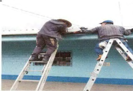
Foto 5: CANALES Y BAJADAS DE AGUA FLUVIAL
