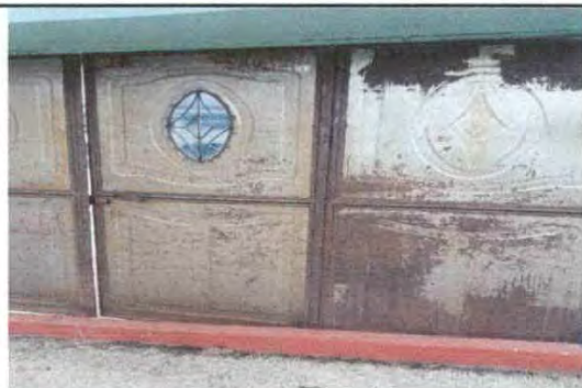
Foto 5: MANTENIMIENTO A PORTONES
