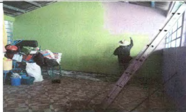
Foto 2: PINTURA EN MUROS EXTERIORES E INTERIORES
