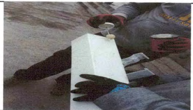
Foto 6: CANALES Y BAJADA DE AGUA FLUVIAL
